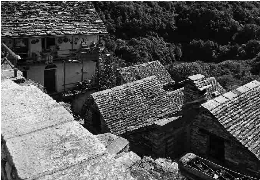
5 Dal sagrato, vista sui tetti in pioda
