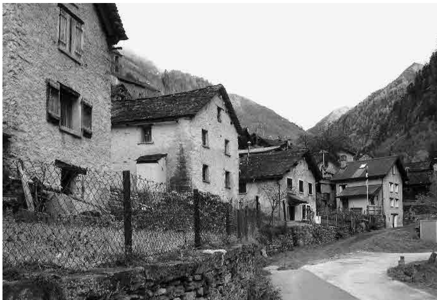
2 Edifici abitativi lungo la strada in arrivo da Malvaglia
